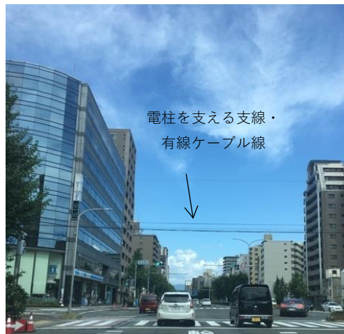
写真 2：電柱を支える支線や有線ケーブル線 （堀川通高辻）
