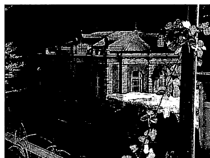
御所水道のポンプ室
